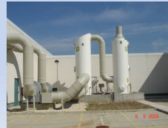
Controlo de Odores
