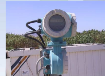
Dispositivos de controlo e medição
