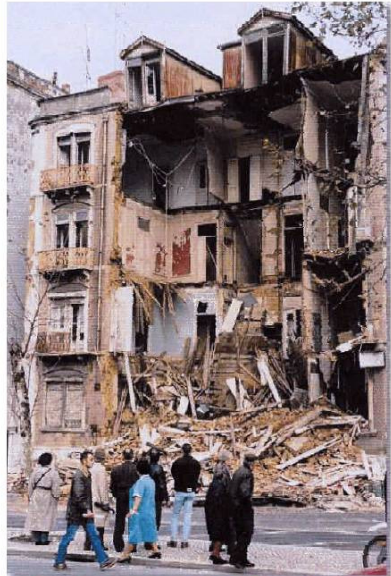
Mesmo sem sismos as casas vêm constantemente abaixo. Agora, imagine-se perante um tal fenómeno
