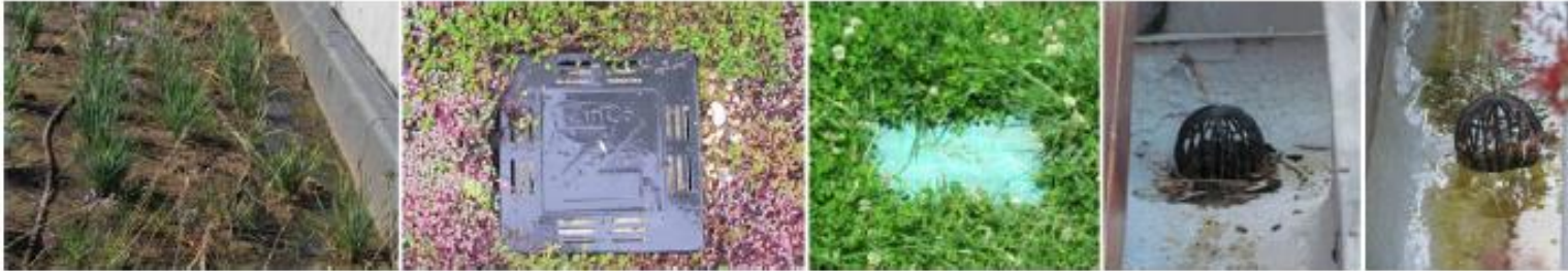
Fig. 3.14 - Registo fotográfico das anomalias: Encharcamento da cobertura XI; Caixas de visita cobertas com vegetação nas coberturas II e IX; Acumulação de resíduos/sujidade nas caleiras e permanência de água nas caleiras na cobertura V
