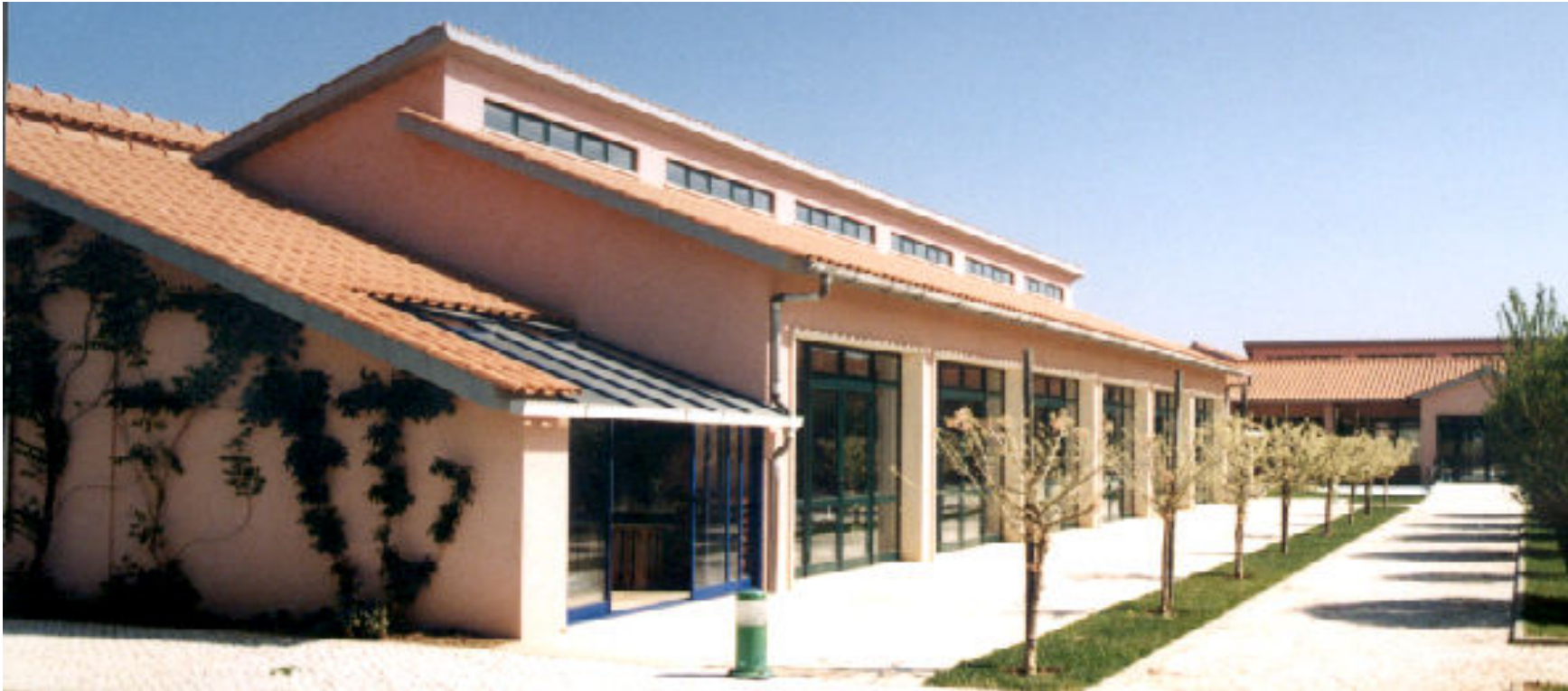
Centro de Recuperação Infantil de Ferreira do Zézere, 1985 Arq. Francisco Moita
