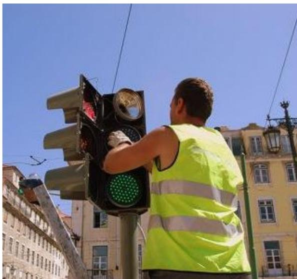
Figura 16 – Substituição de lâmpadas incandescentes por ópticas LED nos semáforos da Baixa.
